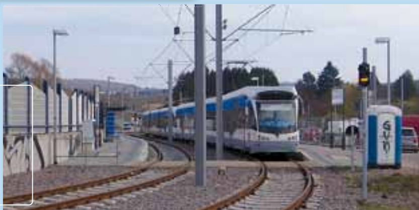
Der Durchbruch ist geschafft: Hier wird die Saarbahn aus der Ortsdurchfahrt Riegelsberg auf die alte Bahntrasse nach Lebach einschwenken. Die Bauarbeiten sind in vollem Gang.
