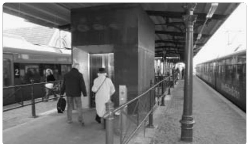
GVFG-Mittel für das Schienennetz: Beispielsweise Aufzüge werden damit finanziert.
