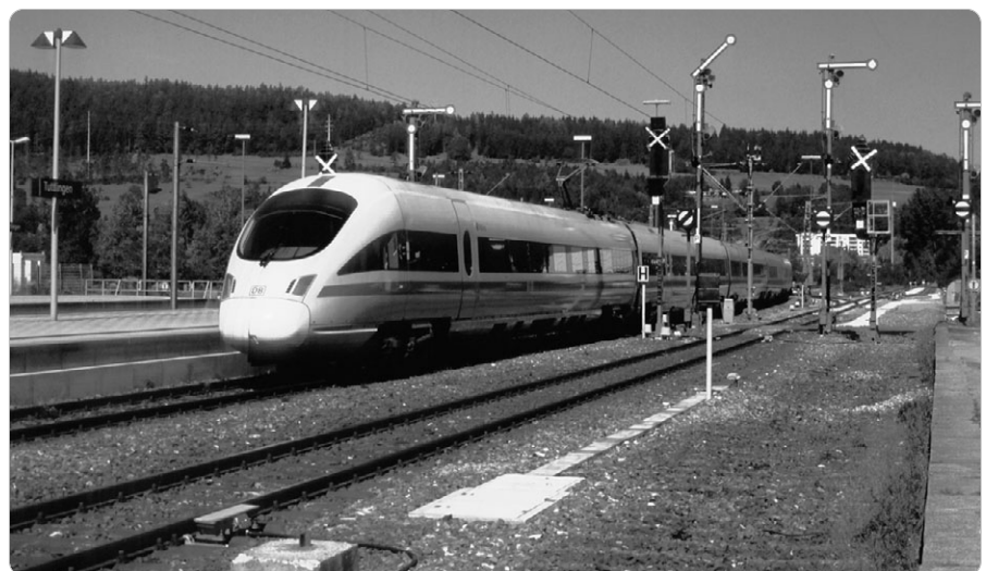
Bis vor kurzem war in Tuttlingen noch Signaltechnik aus den 1930er Jahren in Betrieb. Im Rahmen des ESTW-Umbaus wurde auch im Knotenbahnhof Tuttlingen ein Durchfahrtgleis (im Vordergrund!) wegrationalisiert.
