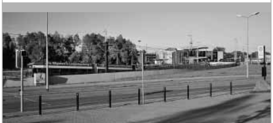
Die Straßenbahn taucht ab: Einfahrt in den Tunnel am Südausgang.
