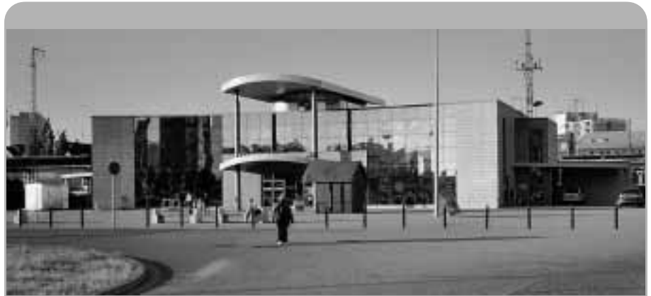
Neues Empfangsgebäude am Südeingang ohne ebenerdigen Zugang zur Unterführung. Die Straßenbahn fährt ein Stockwerk tiefer als nötig.
