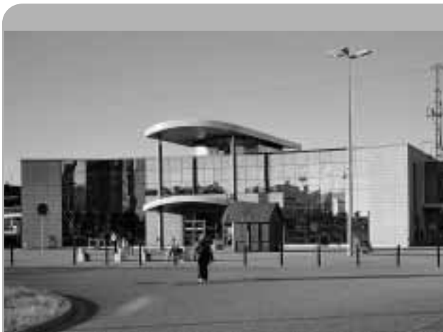
Neues Empfangsgebäude am Südeingang ohne ebenerdigen Zugang zur Unterführung.
