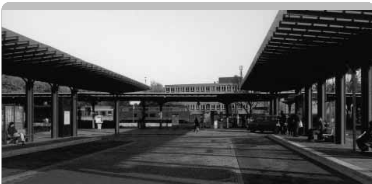
Der Erwerb der Flächen für Verknüpfungspunkte ist meistens das größte Hindernis: Busbahnhof Goslar.
