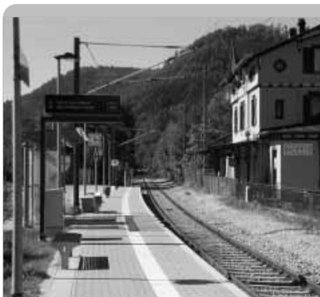
So sieht Sparsamkeit aus: Saniert und elektrifiziert von der Albtal-Verkehrsgesellschaft wurde die Bahnlinie Pforzheim – Wildbad, hier am Bahnhof Höfen (Enz).
