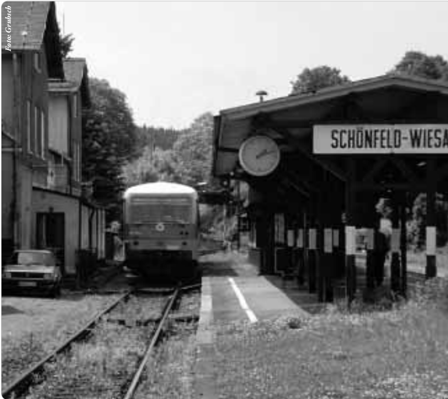
Das Erbe der Erzgebirgsbahn: eine verfallene Strecke, hier in Schönfeld-Wiesa.
