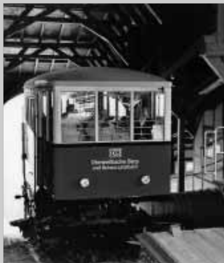
In der Bergstation Lichtenhain (a d Bergbahn).
