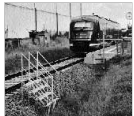
Tessin: Eine eiserne Treppe in den Graben zeugt davon, dass der Bahnsteig zu kurz ist. Über diese Treppe erreicht der Lokführer des Frühzugs seinen Führerstand.
