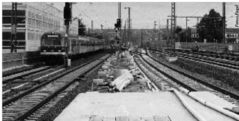
Über Investitionen entscheidet der DB-Vorstand – das veranlasst Bundesländer zum Wohlverhalten: Großbaustelle Siegburg für die Neubaustrecke Köln – Frankfurt.
