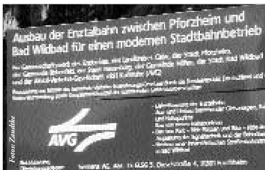
Die Bauarbeiten haben begonnen!
