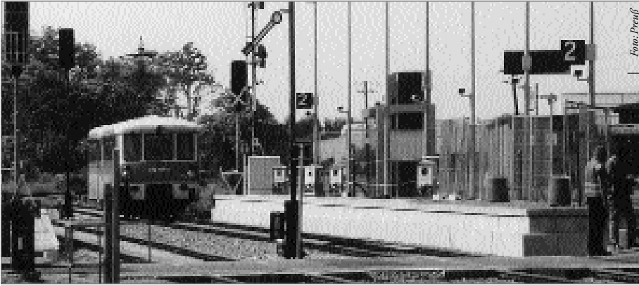
Alter Triebwagen am neuen Bahnsteig: Neuruppin West.
