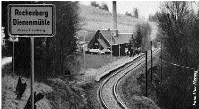
Schienen in die Zukunft: der Haltepunkt Rechenberg.
