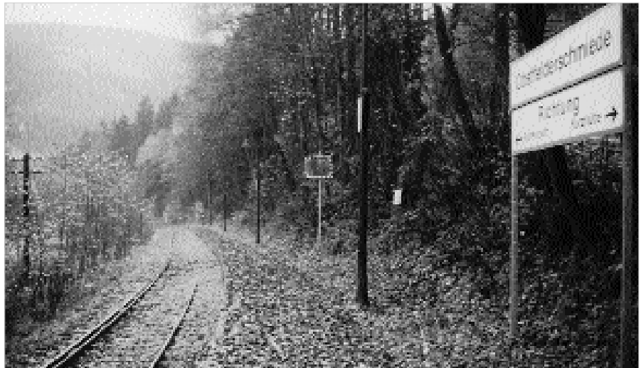
Das Netz ist ein ungelöstes Problem: Illegal stillgelegte Strecke nach Katzhütte in Thüringen – wann lichtet sich der Nebel?
